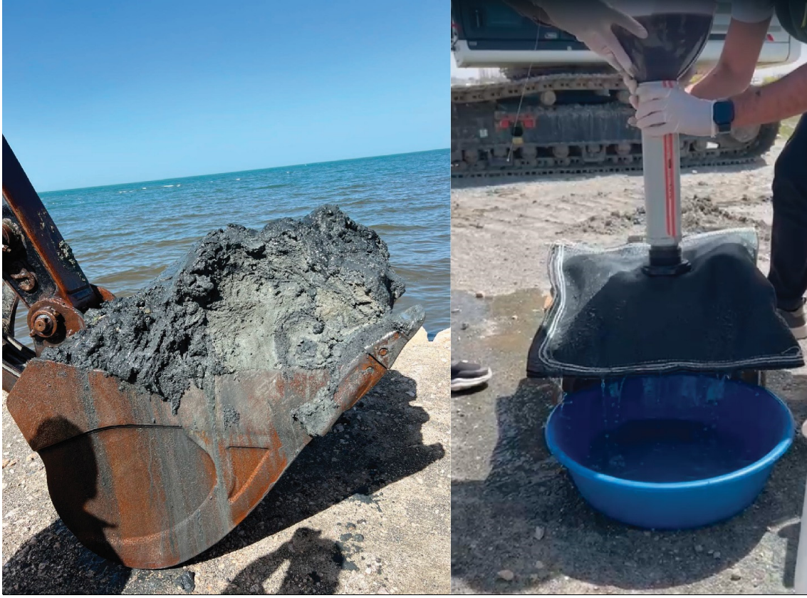
Şekil 4. Flokülasyon işlemi ve geotekstil tüpler ile susuzlaştırma işlemi
